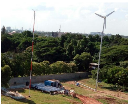
चित्र 23 कोडिहल्ली कैंपस के रीनोवबल एनर्जी फार्म में 10 kW WiSH प्रणाली।
